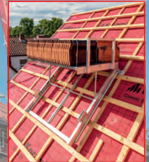
Dachziegelverteiler (Alu) - zweireihig
